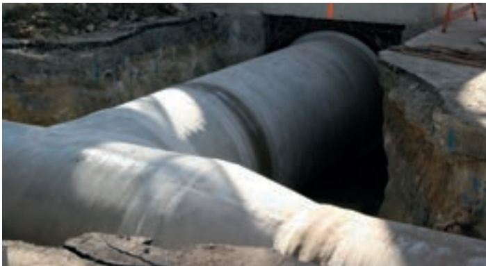
Conducto principal de pared doble de 48" de diámetro
