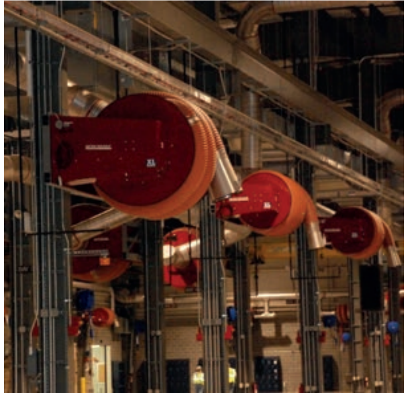
Carretes XL instalados en Ft. Lee
