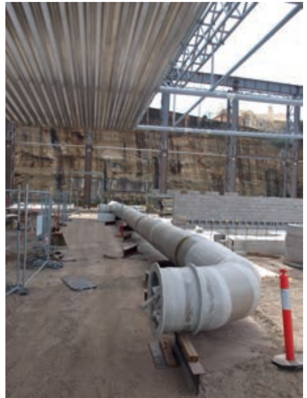
Conducto derivado de pared doble de 24" de diámetro
